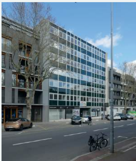
Avant rénovation et restructuration
