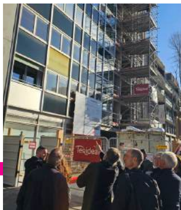
MARS Visite du logement témoin du chantier de transformation de bureaux en logements à Viroflay, 108-110 av. du Général Leclerc
