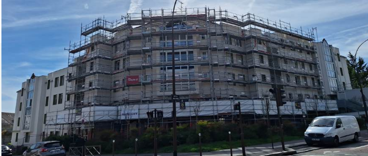
« Hameau Saint-Nicolas » en cours de réhabilitation
