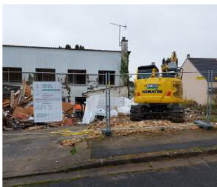
Avant démolition et reconstruction
