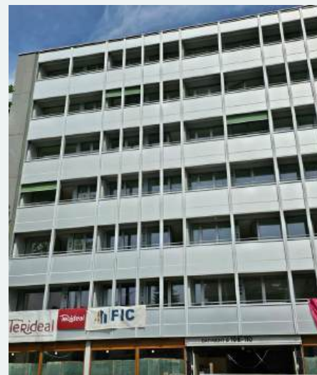
En cours de travaux
