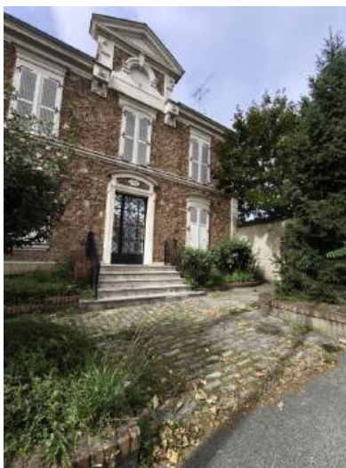
« Ancienne mairie » de Rocquencourt
