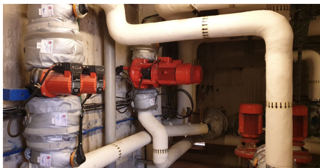
Calorifugeage de points singuliers au 11 allée du Commerce au Pont du Routoir/Guyancourt
