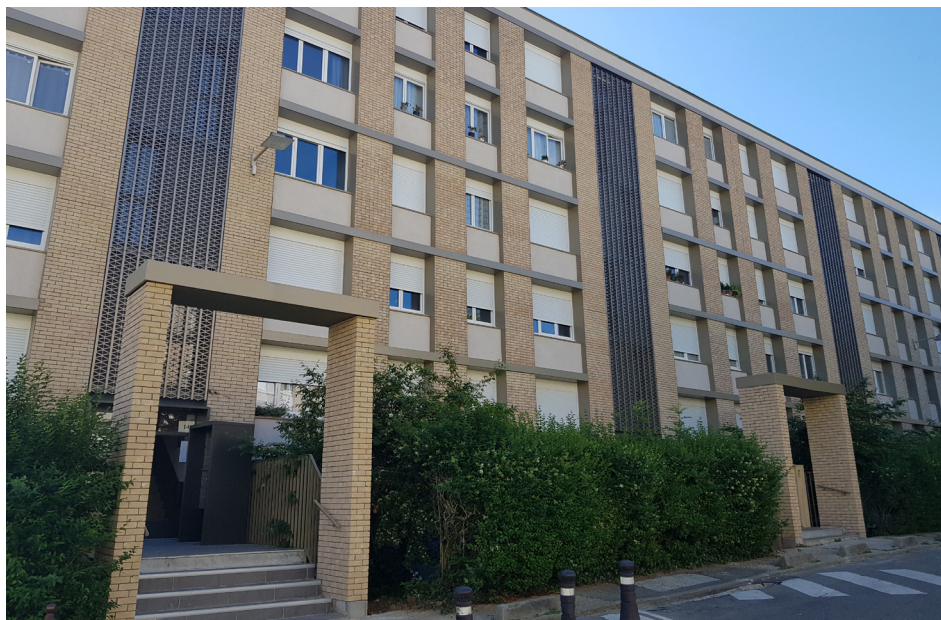
Façade réhabilitée de la résidence Bernard de Jussieu par des parements de briques isolants
