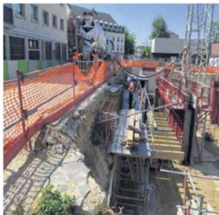
Rue Hausmann, le chantier de la future maison de quartier et des logements a pu reprendre.
