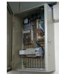
> Armoire de commande avec boîtier GSM.
