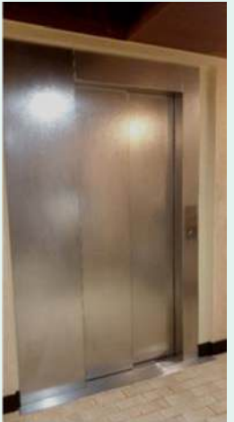
> Porte palière Saint-Charles après travaux
