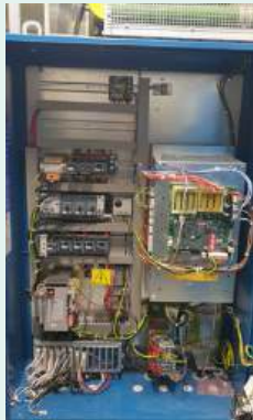
> Armoire manœuvre 18 rue des Fédérés après travaux
