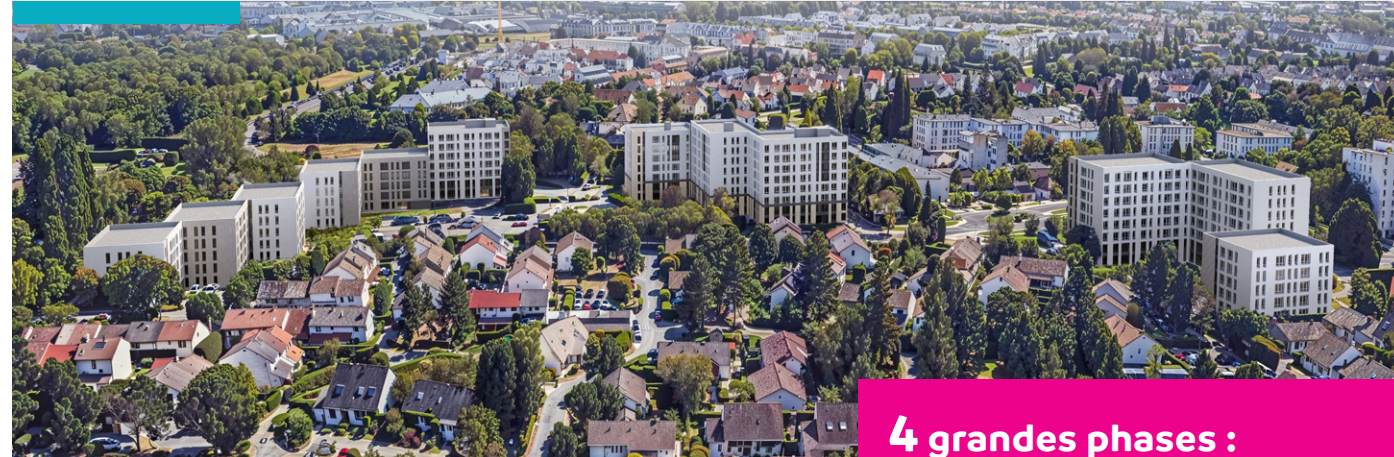
Vue d'ensemble des bâtiments du Pont du Routoir réhabilités.
